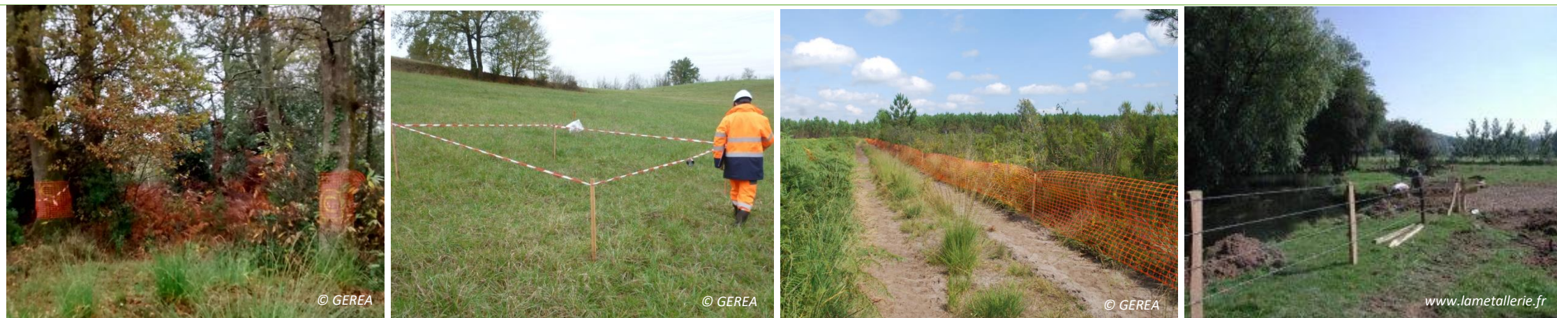
De gauche à droite, exemples de mises en défens : marquage d'arbres, piquets et rubalise, filet de balisage de chantier, clôture type agricole.
